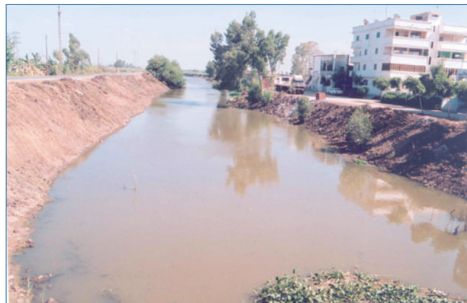
Upper Serw Drain
