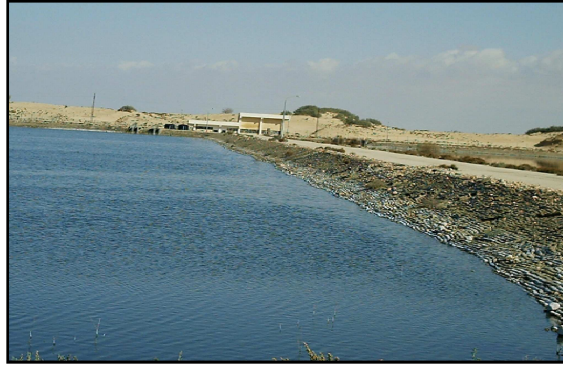
شكل (17) أحد أحواض الصرف الصحي بمنطقة جرادة بالعريش
