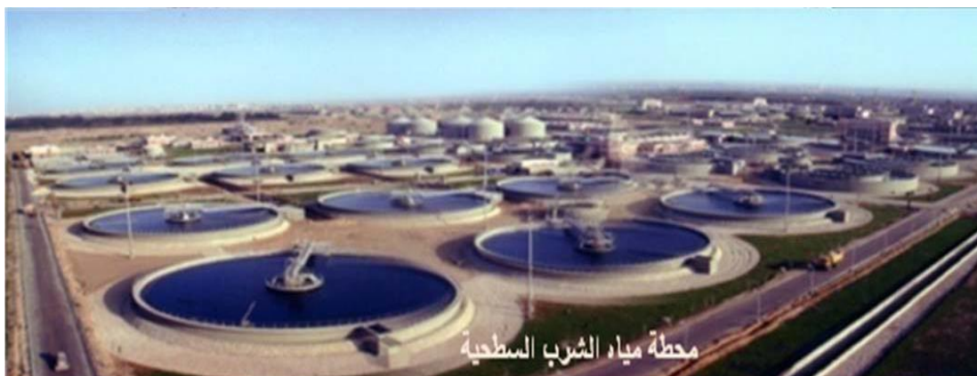
صورة - ٣ - محطة مياه الشرب السطحية
