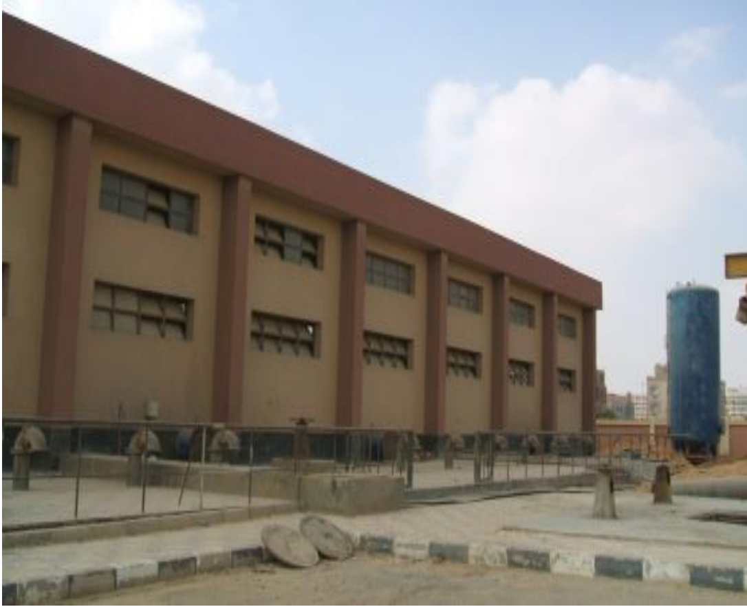
صورة -٣٥- صورة عنبر ظلمبات محطة الصرف الرئيسية بالتجمع الخامس
