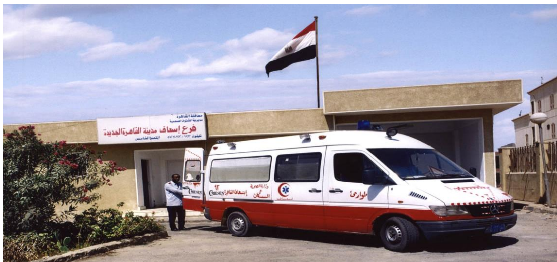
صورة ٧٦- مركز اسعاف بالتجمع الخامس
