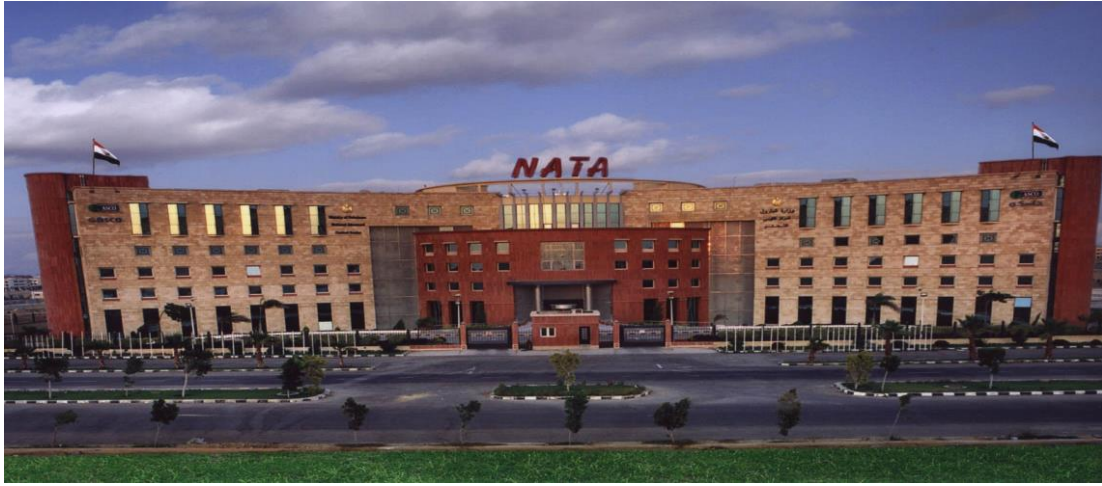
صورة ٨٨- المركز القومي للتحكم ( ناتا ) بقطاع البترول
