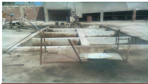
صورة رقم (١٦-١) بيارة تجميع رئيسية مكونة من ٦ أحواض بمناسيب مختلفة لفصل الشحوم والدهون
