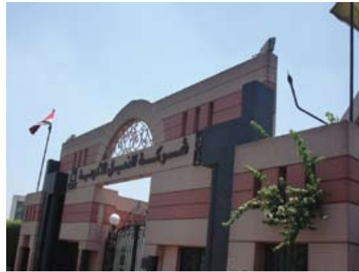
صورة (٣-٤) محطة رصد الضوضاء بمنطقة صناعية بمحافظة القاهرة
