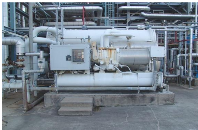
صورة (٣-٣) وحدة تبريد مركزية تعمل بغاز (R-12) المستنفدة لطبقة الأوزون
