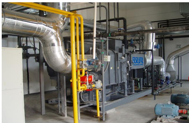
صورة (٣-٤) وحدة تبريد مركزية صديقة للبيئة تعمل بطريقة الإمتصاص
