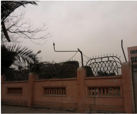
صورة (١-٤) : محطة الرصد الكائنة بمحطة كهرباء جنوب - حلوان
